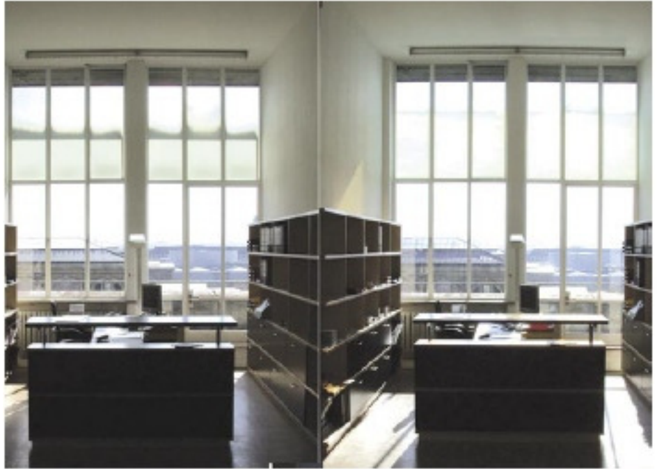
Bild 3: Nach dem Umbau bieten u. a. thermotrope Gläser Schutz gegen Überhitzung. Links im Bild sind die Gläser fast komplett transparent geschaltet (oben), während im rechten Bild der Schaltungsprozess gerade beginnt.
