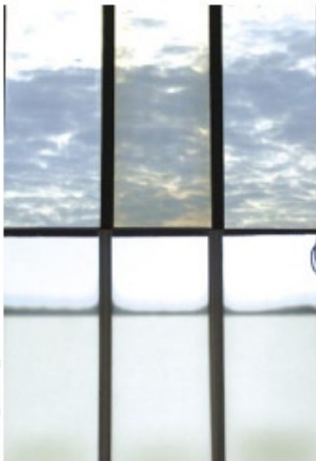
Bild 4: Die Wirkung der thermotropen Gläser im Detail: oben ungeschaltet d. h. transparent und unten im geschalteten (transluzenten) Zustand. Bei der mittleren oberen Scheibe setzt gerade der Schaltungsprozess ein.
