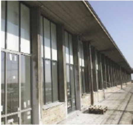
Bild 2: Im Rahmen von Instandsetzungsarbeiten wurde nicht nur die ursprüngliche Fassadenoptik des verglasten Dachgeschosses wieder hergestellt, sondern auch ein zeitgemäßer Sonnenschutz installiert.
