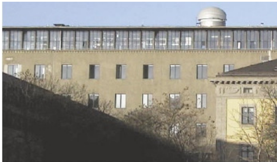
Bild1: Ein "gläsernes" Obergeschoss aus den fünfziger Jahren krönt das Hauptgebäude der TU München
