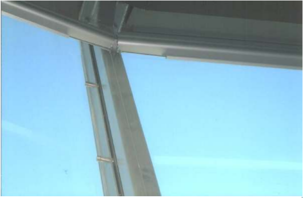
Befestigung der Rollogehäuse (der Blendschutz ist eingefahren - Trapez Form)
