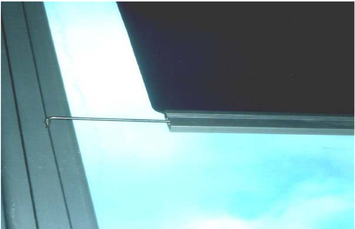
Teleskopisches Führungssystem der Endstäbe, das über ummantelte Inox Spanndrähte gleitet und verhindert, dass die Folie auf dem Glas klebt.
